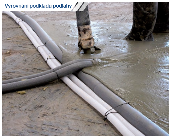
Vyrovnání podkladu podlahy
