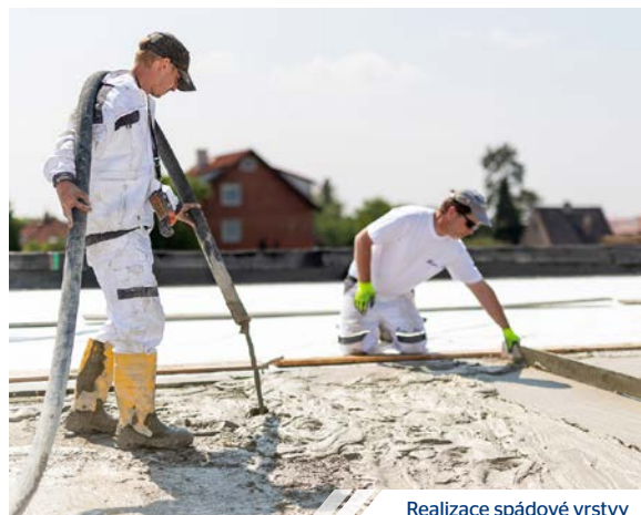
Realizace spádové vrstvy
