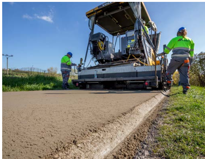
Vysoká pevnost dosažená vysokou mírou zhutnění pomocí dvoustupňových pěchů.
