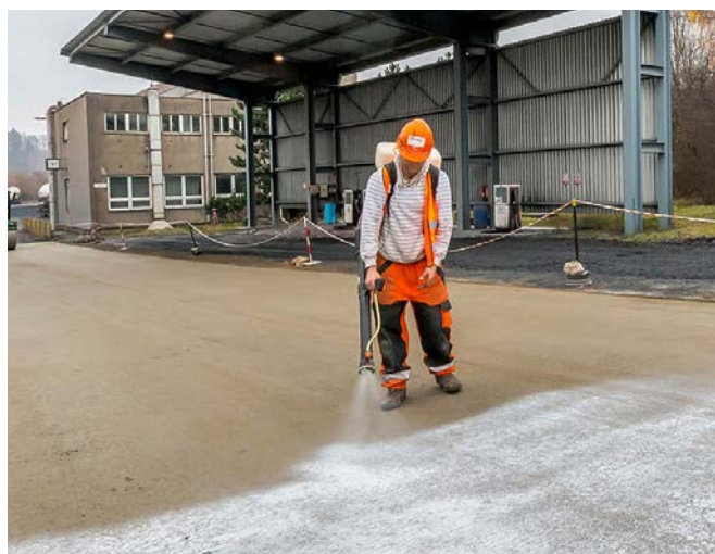
Ošetření zajišťující řádné vyztužení cementového pojiva.
