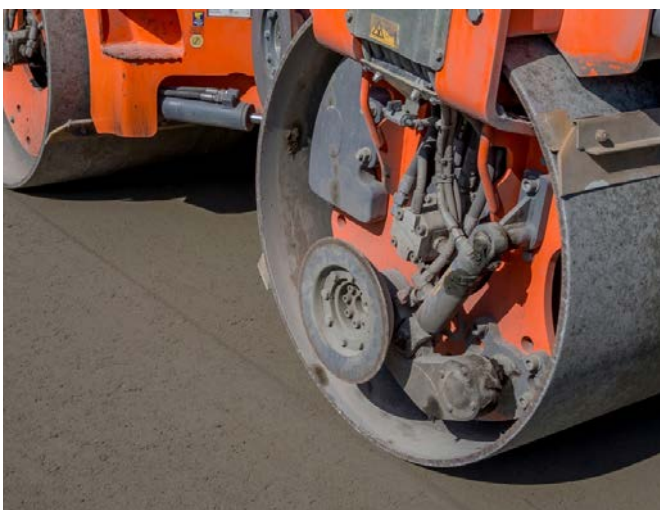
Válcováním je dosaženo velmi kvalitního a kompaktního povrchu.
