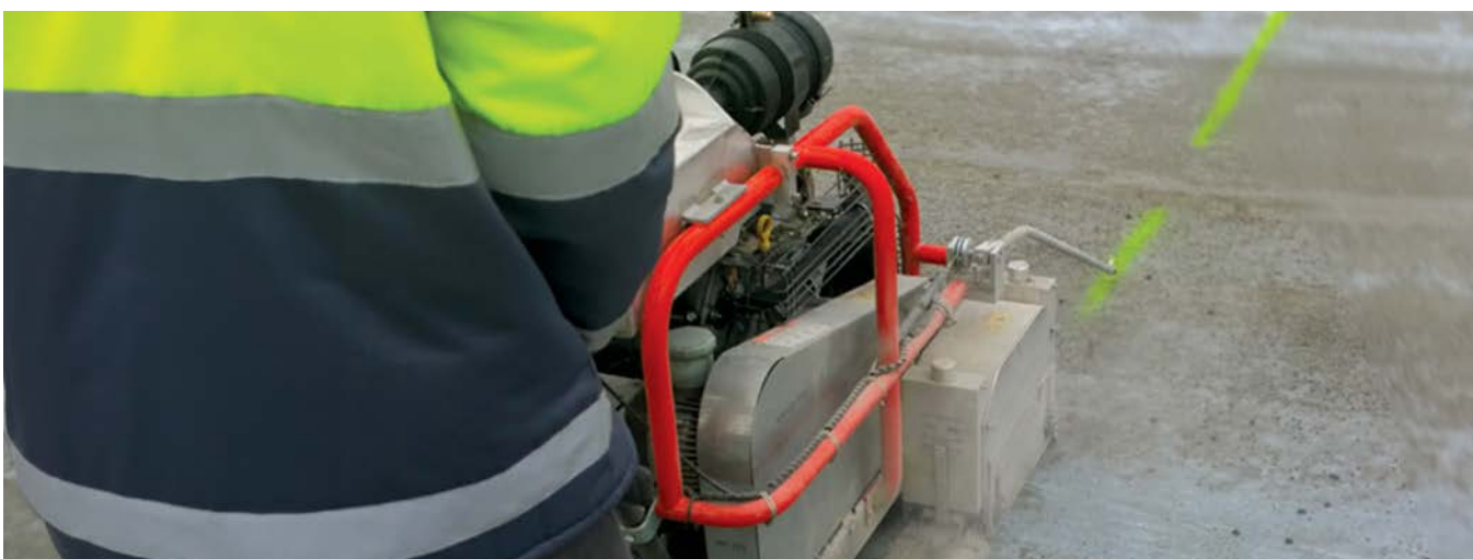
Provádění dilatací.
